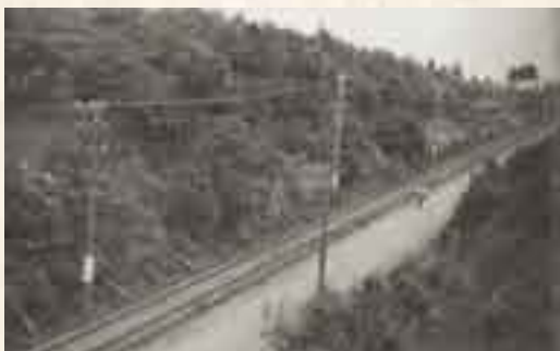
単線化された軌道。写真右上が現在の赤坂消防署公津分署付近(出山隆さん所蔵)
